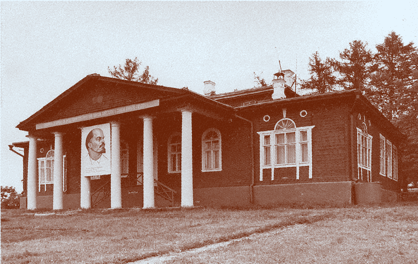
Здание бывшего земского начального училища в Филатове (не сохранилось). 1976 год. Фото А. Галашкевича
