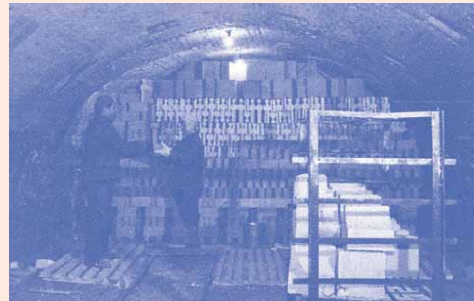
Садка продукции в кольцевую печь Снегирёвского огнеупорного завода. Середина XX века
