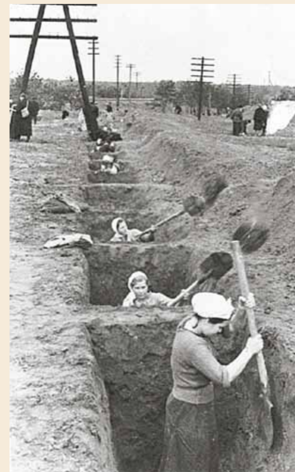
Строительство оборонительных сооружений на подступах к Москве. 1941 год
