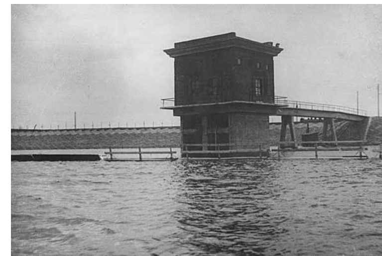
Истринская земляная плотина. Башня донного водоспуска
