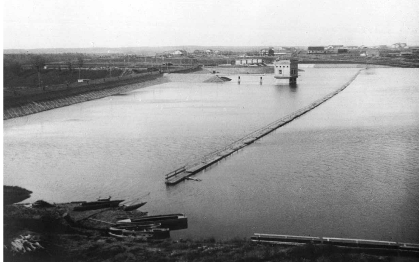
Общий вид Истринской земляной плотины со стороны водохранилища
