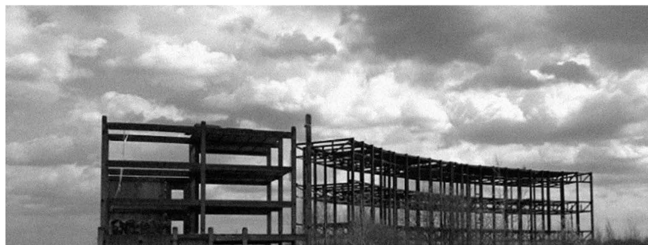
Недостроенный производственный корпус ЦИЭ. 2015 год
